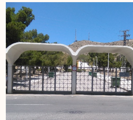
Puerta de acceso principal del Parque de San Crispín
